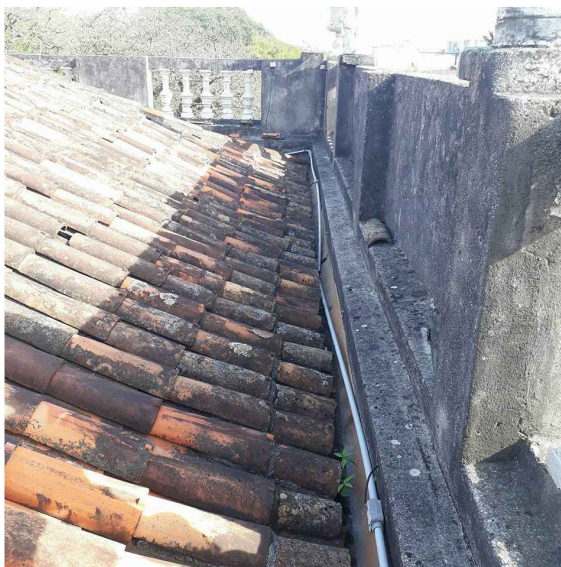
FOTOS GERAIS DAS COBERTURAS
